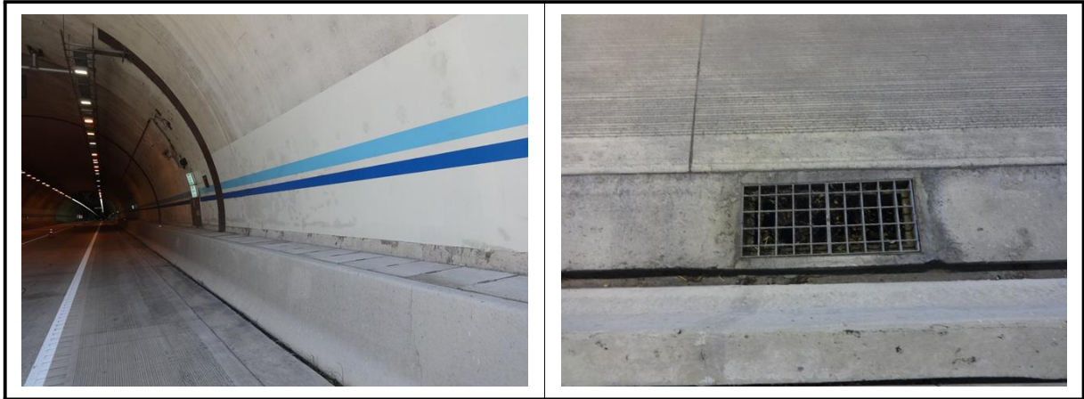
【사진 1.3.21】 공동구 및 배수시설 전경
