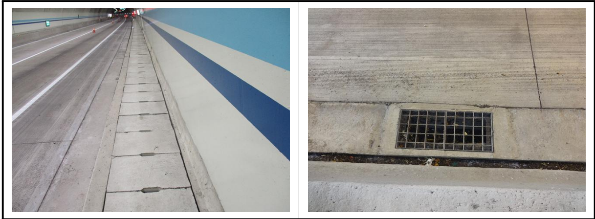
【사진 1.3.8】 공동구 및 배수시설 전경
