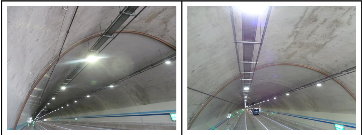
【사진 1.3.1】 라이닝 천단부 전경
