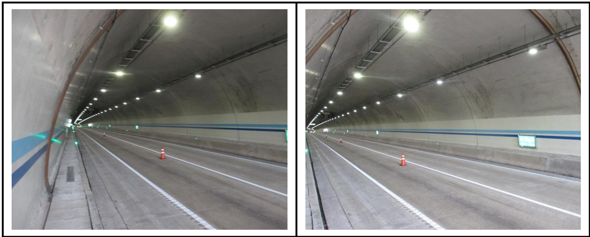
【사진 1.3.3】 라이닝 측벽부 전경
