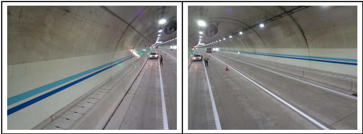
【사진 1.3.16】 라이닝 측벽부 전경
