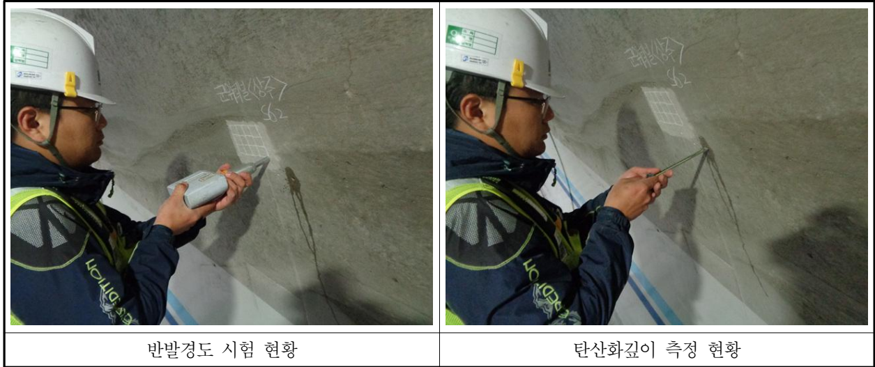
【사진 1.4.1】 콘크리트 내구성조사 현황
