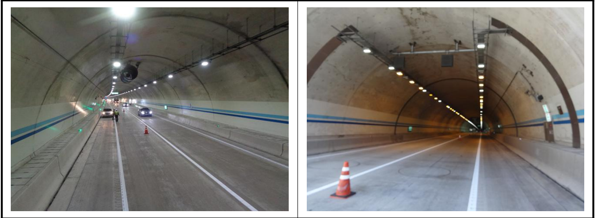
【사진 1.3.23】 포장부 전경
