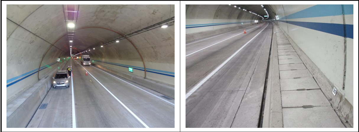
【사진 1.3.10】 포장부 전경
